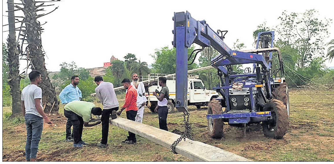
କାଳବୈଶାଖୀ ପରେ ବିଦ୍ୟୁତ୍ ସେବା ବୁଲାଇ ଦେବା ପାଇଁ ବିଦ୍ୟୁତ୍ ବିଭାଗ ପକ୍ଷରୁ ନୂଆ ଖୁଣ୍ଟ ପୋତାଯାଉଛି।
